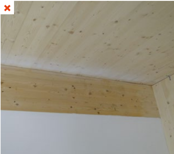
Des traces de projections de peinture sont visibles sur le plafond en bois qui a mal été protégé
